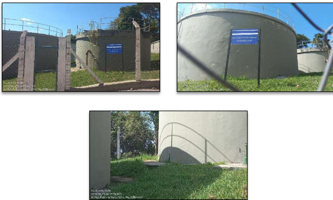
Figura 63 - Reservatório RAP-01 e RAP-02.
