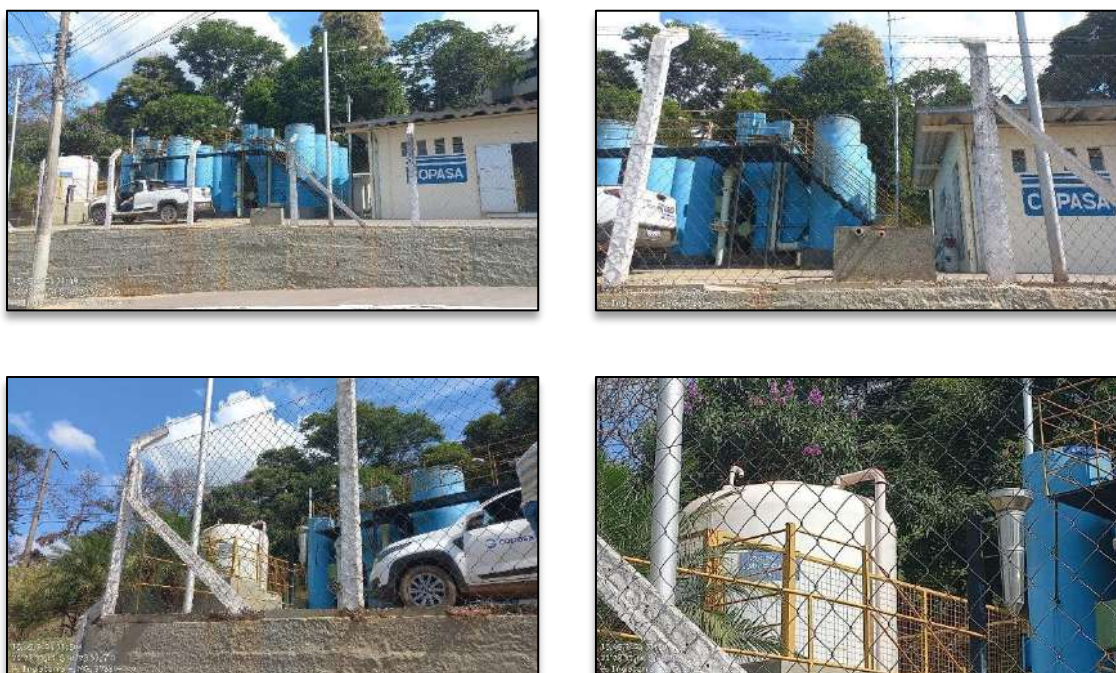
Figura 58 - Instalações da ETA.
