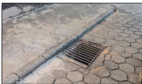
Figura 100 - Sarjetas, meios-fios e bocas de lobo existentes no município de Cabo Verde/MG
