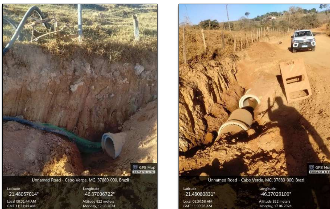
Figura 110 - Obras de drenagem na zona rural.
