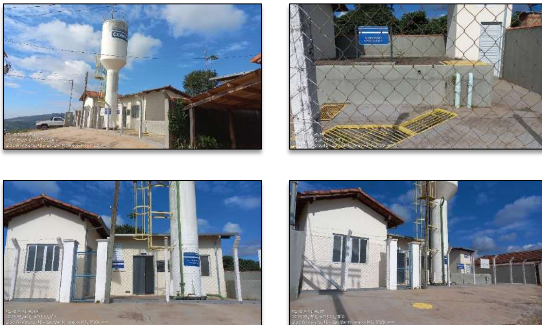
Figura 71 - Reservação - Distrito de São Bartolomeu de Minas.
