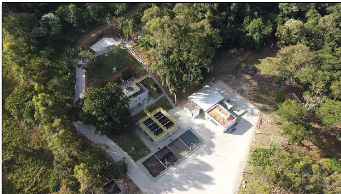
Figura 88 - Vista aérea da ETE - Cabo Verde/MG.
