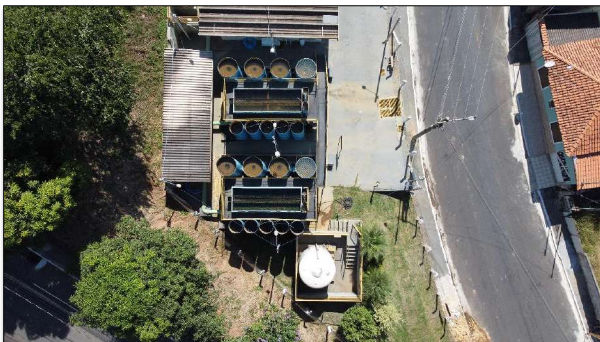
Figura 56 - Vista aérea da ETA - Cabo Verde/MG.
