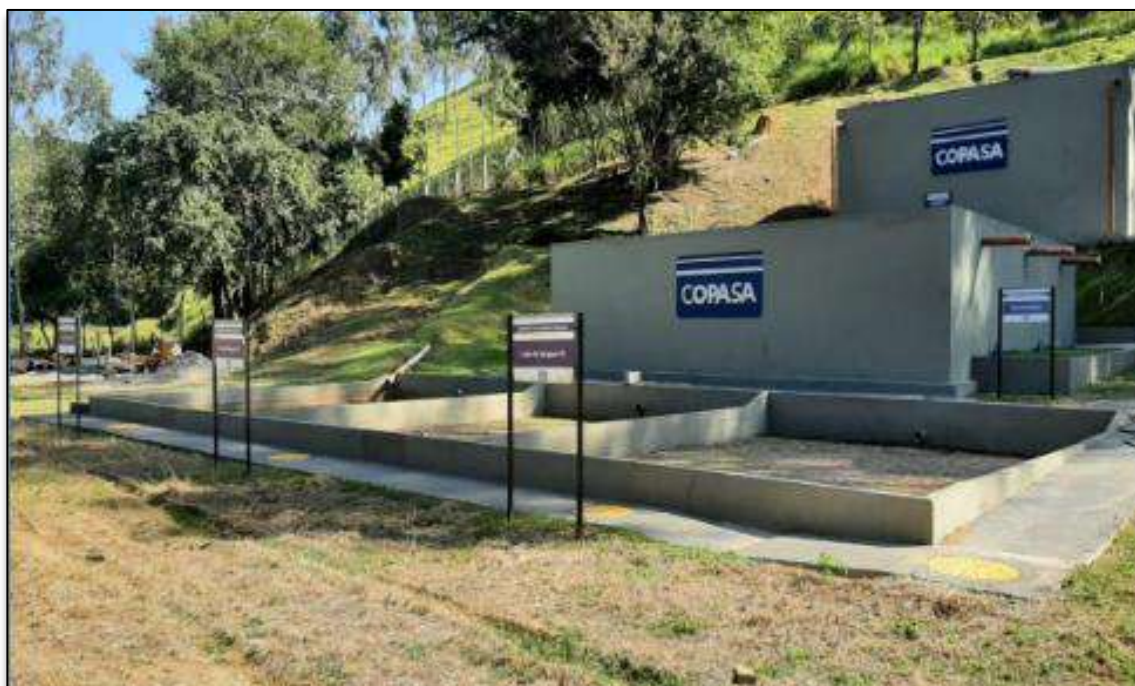
Figura 92 - Leitos de secagem.
