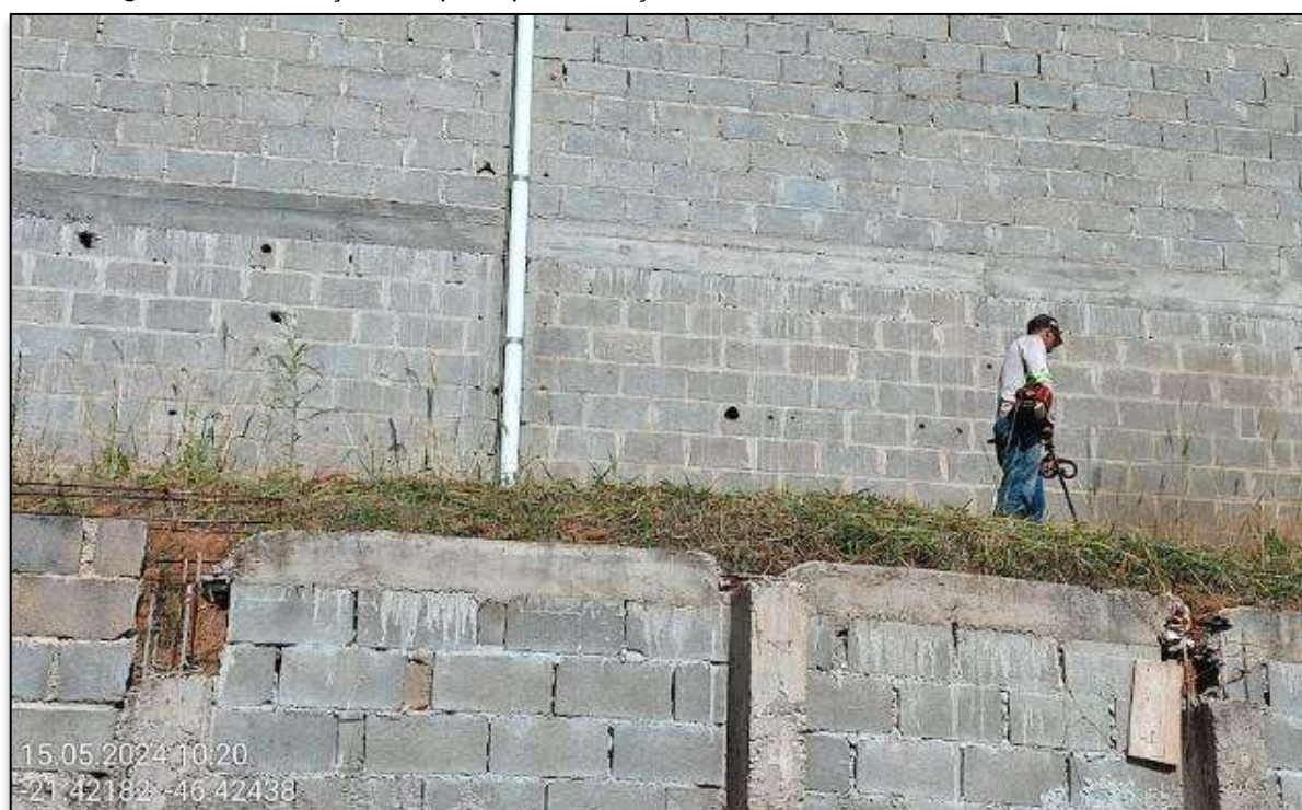
Figura 115 - Serviço de capina, poda e roçada no Distrito de São Bartolomeu de Minas.
