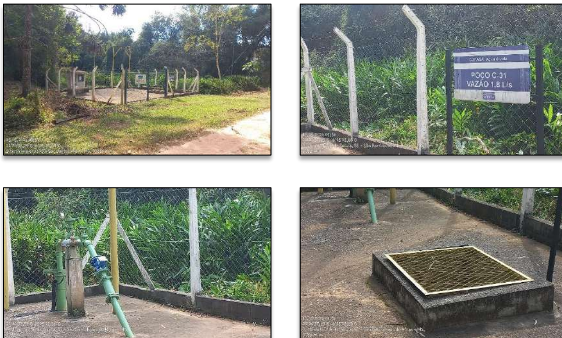
Figura 70 - Poço C-01 - Distrito de São Bartolomeu de Minas.
