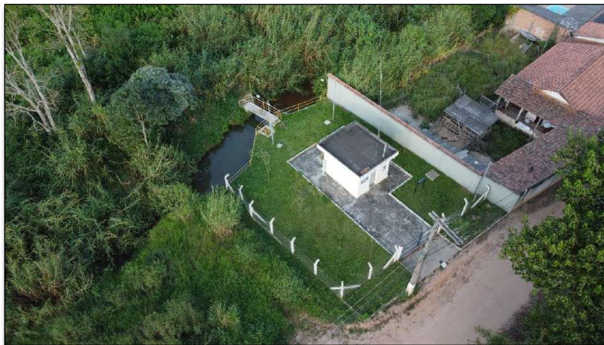
Figura 52 - Vista aérea da captação superficial - Cabo Verde/MG.
