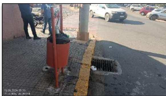
Figura 100 - Sarjetas, meios-fios e bocas de lobo existentes no município de Cabo Verde/MG
