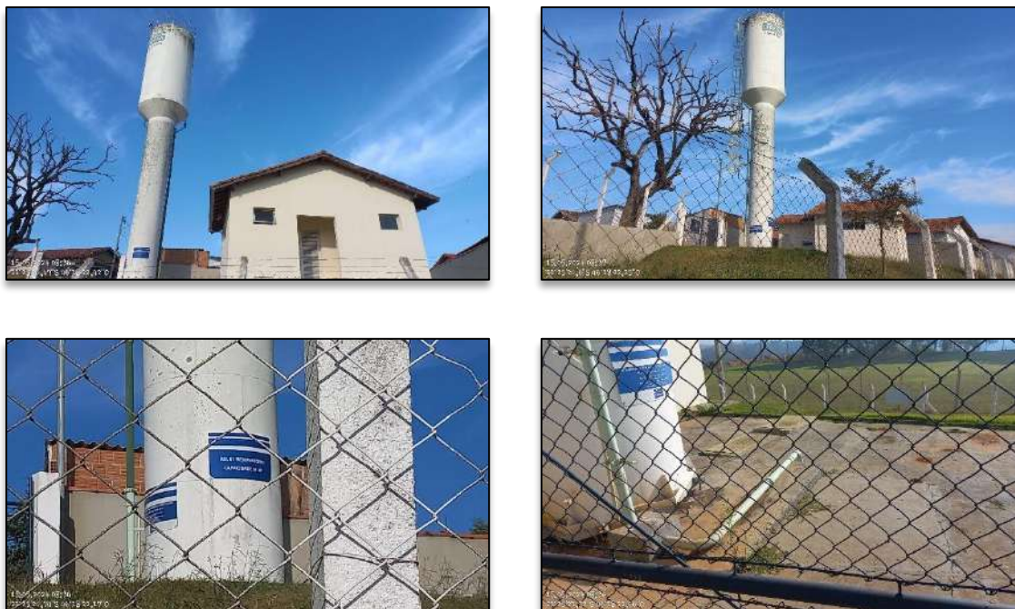
Figura 77 - Reservatório - Distrito de Serra dos Lemes.
