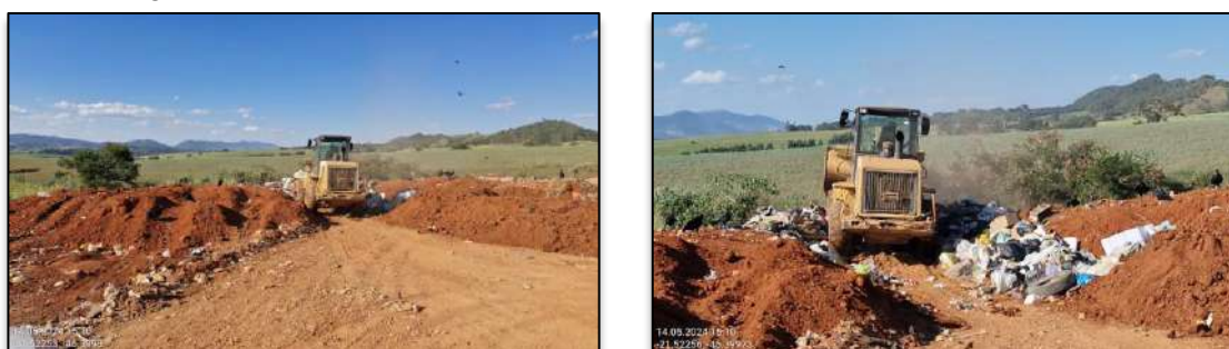
Figura 131 - Retroescavadeira realizando o recobrimento diário dos RSU.
