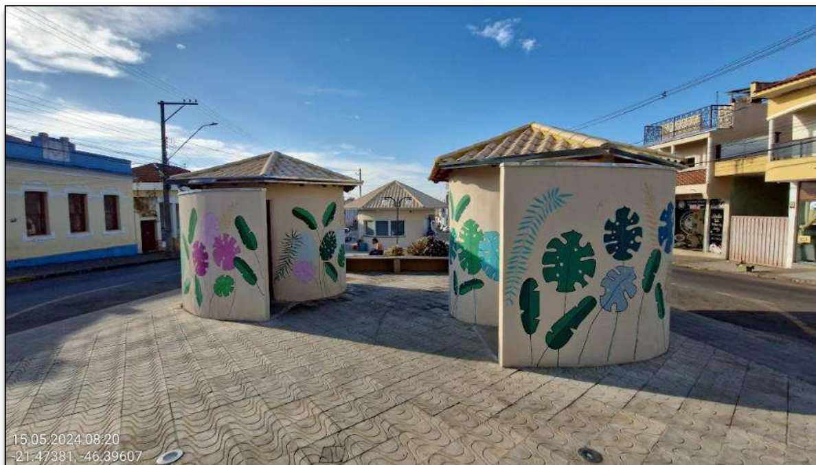
Figura 113 - Banheiros públicos da praça central.
